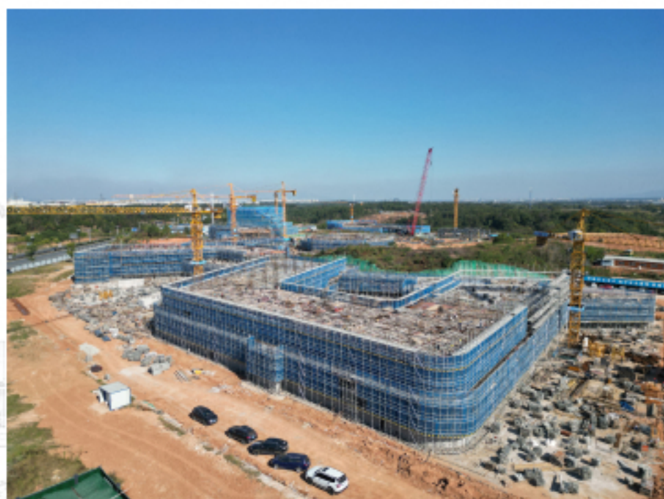
研究院院区建设项目工地施工现场图像记录
